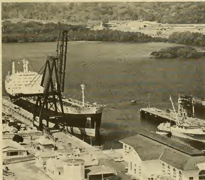
El petrolero "Opalia" es atendido en la Dársena 7 de Balboa, lugar de descarga de petroleros y de abasto de combustible marítimo. En primer plano se ve una grúa pórtico que se usa en el manejo de contenedores.
